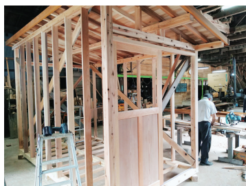
工場を組み立てるため現場施工が早くローコスト
