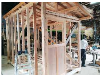
工場で見組み立てるため現場施工が早くローコスト
