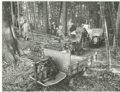
侵入竹の伐採除去
